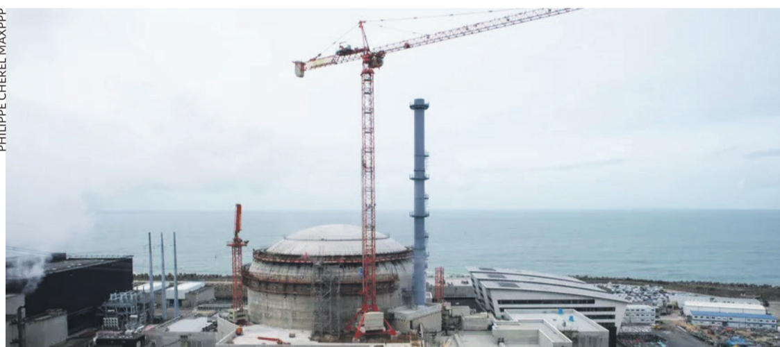
Le chantier de Flamanville.
