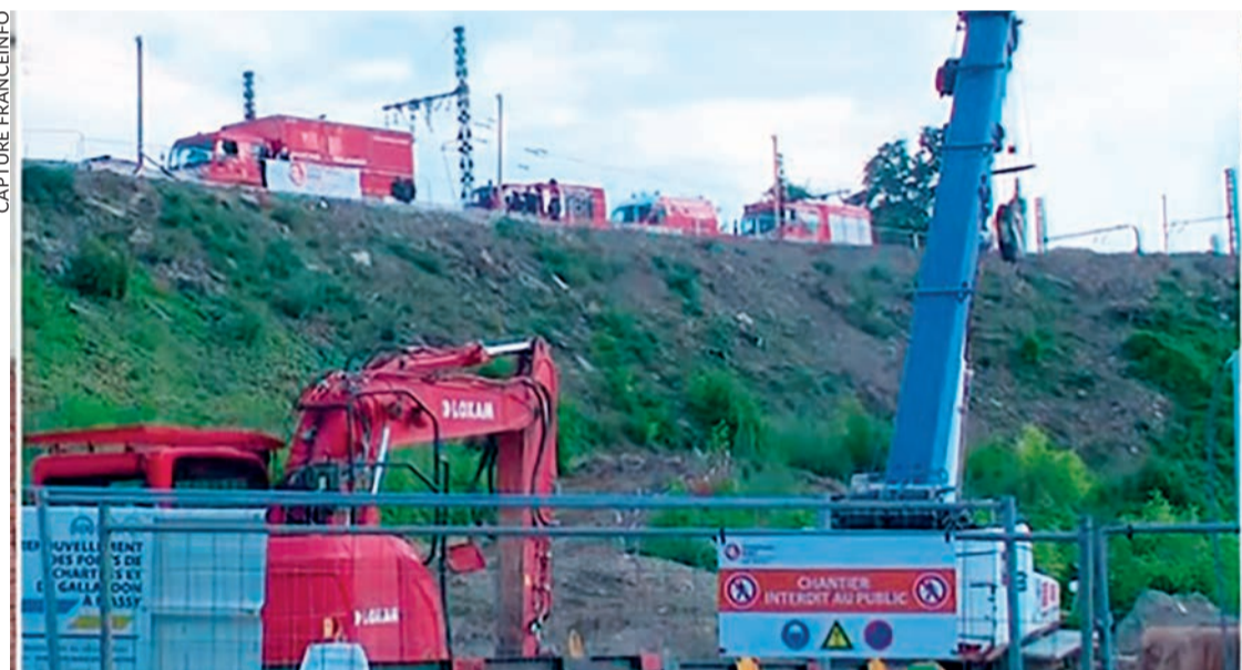
Le chantier de Massy-Palaiseau.
