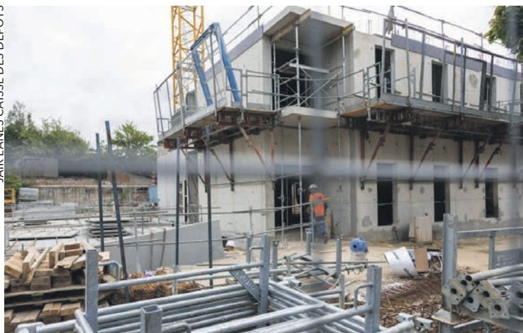
Construction de HLM.
