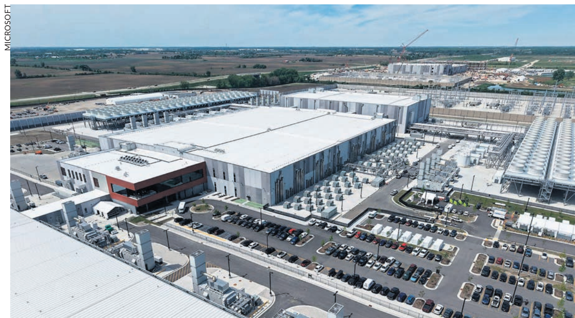
Le data center de Mount Pleasant.
