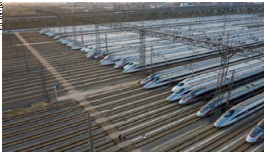
Le développement du TGV chinois s'est accéléré. Ici un centre de maintenance.
